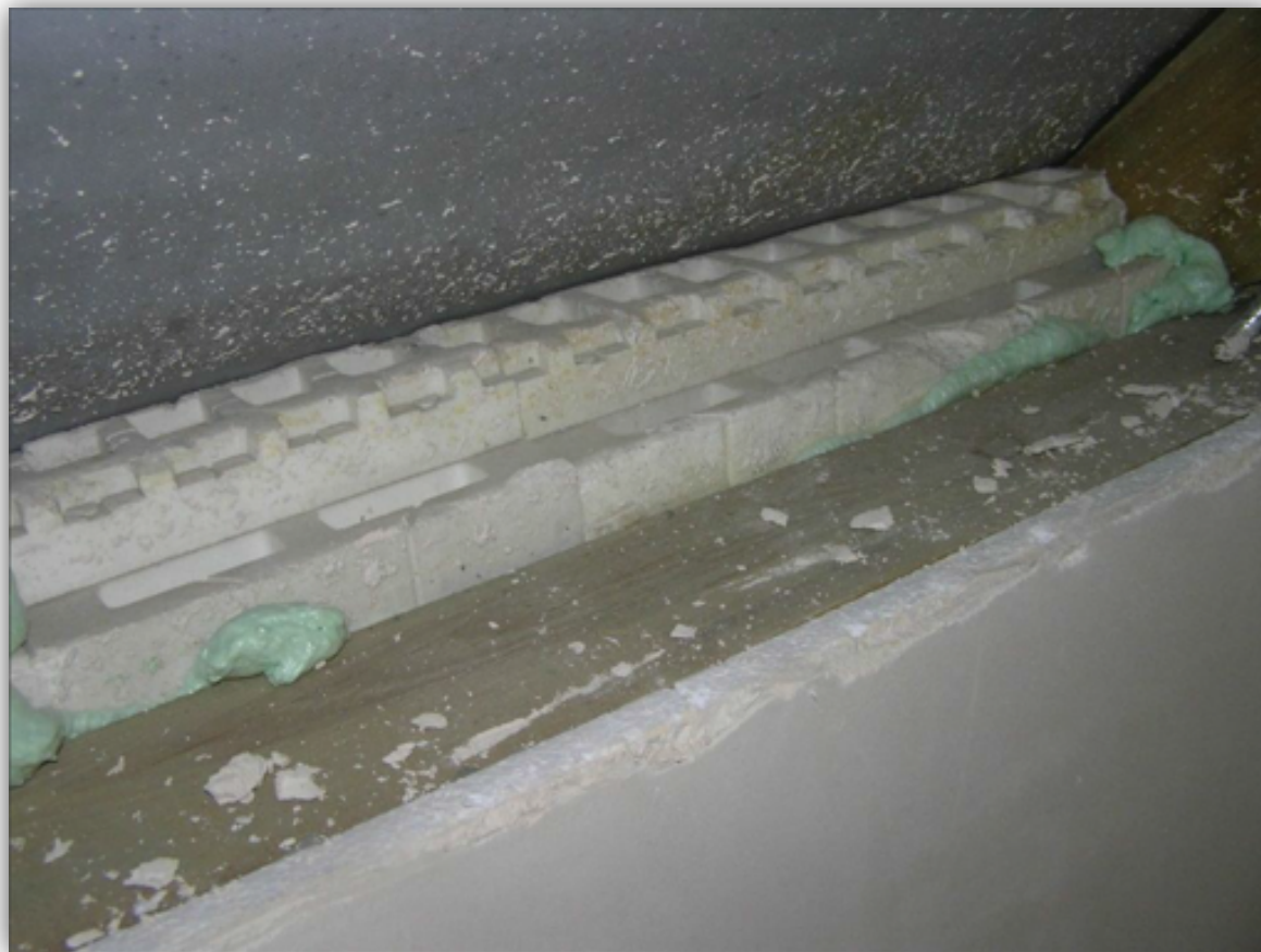
Cosoroabă, căpriori si element izolare acoperiş
