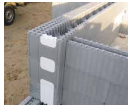
Dacă în timpul construcției apar capete de perete obtuze, închideți deschiderile din cofraj cu elemente OH, OB și OC.
