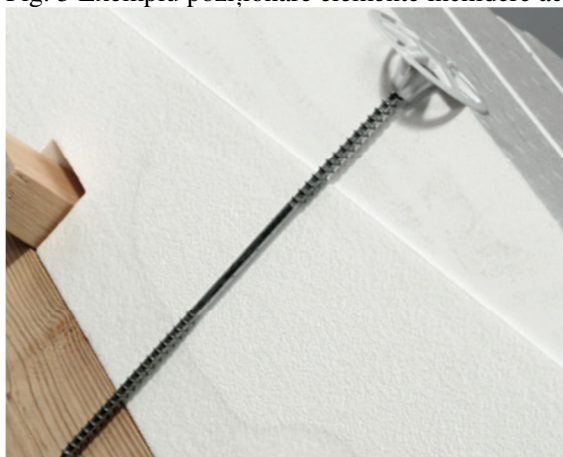
Fig. 5 Exemplu poziționare elemente închidere acoperiș
