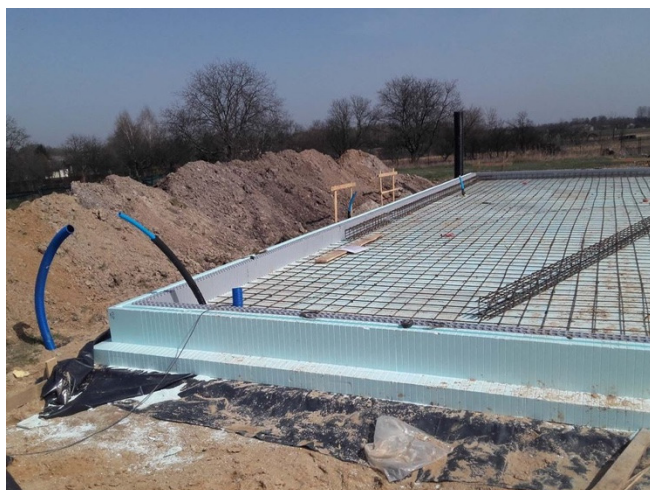
Fig. 1 – Exemplu pernă de balast, vană termică și radier general
